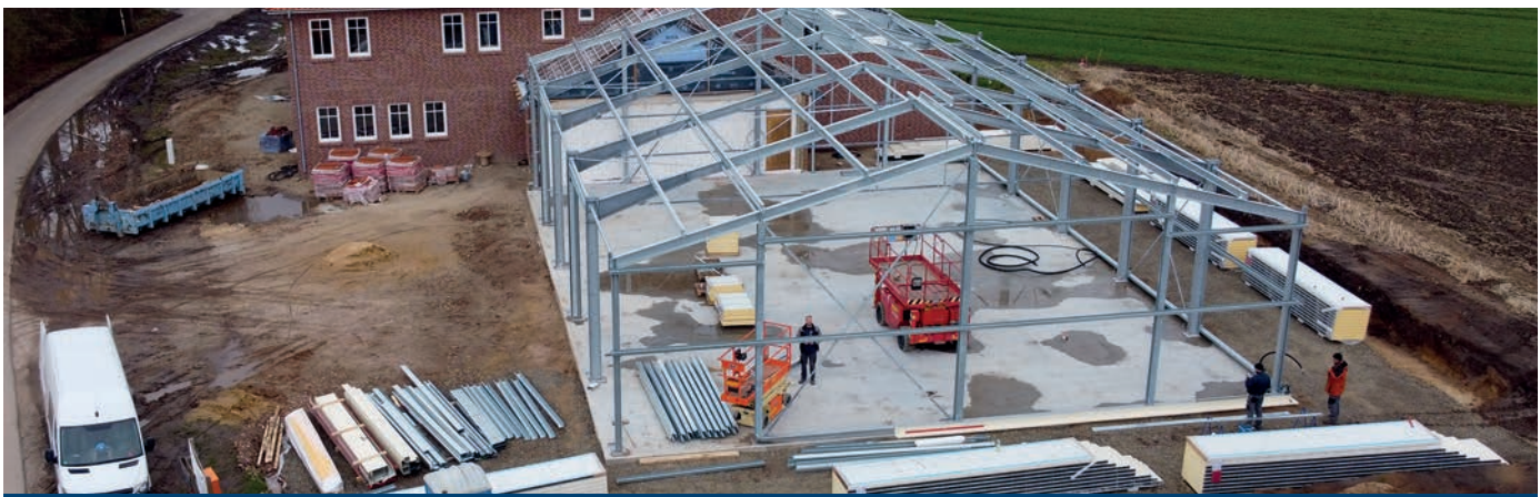
... und die entstehende Fahrzeughalle, ist der Bau des neuen RBZ bereits weit fortgeschritten.
