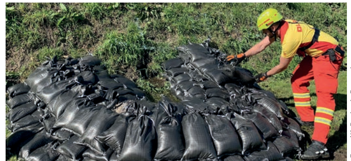
Herstellen einer Quellkade zur Eindämmung der Leckstelle.
