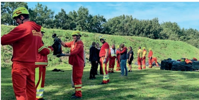
Transportkette zur Beförderung der befüllten Sandsäcke von der Abfüllstation zur Deichleckage.
